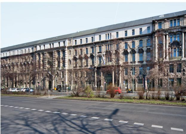
Abb. 6: Denkmal mit überformtem, nicht bauzeitlichem Dach
