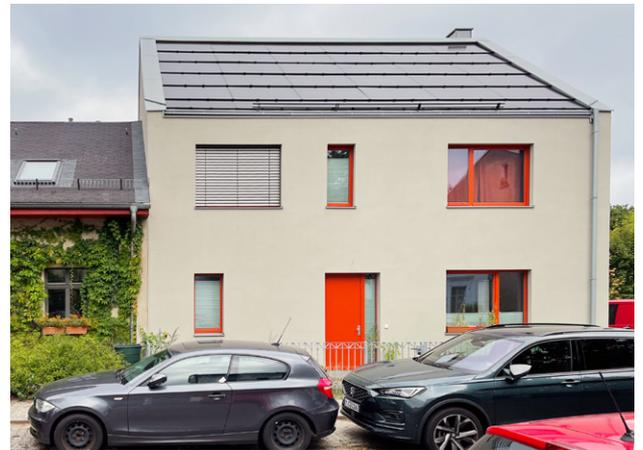
Abb. 8: Dachintegrierte PV-Anlage auf Neubau neben einem Denkmal
