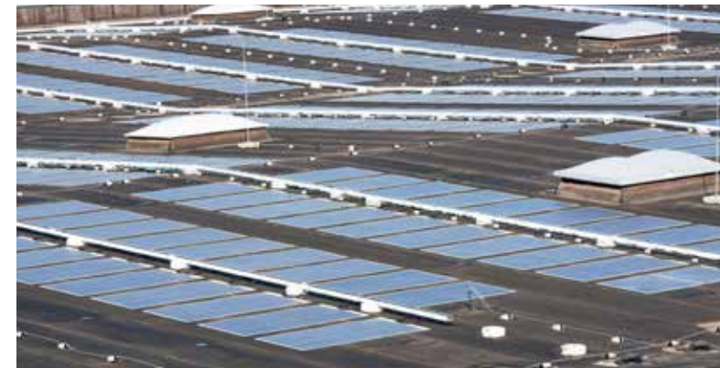
Bitumendach / Bad Vöslau
