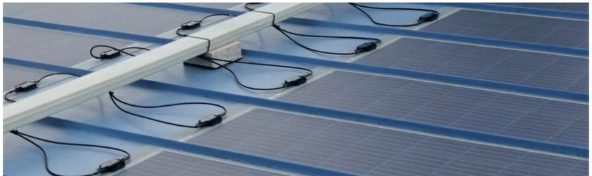
Abb. 10: Beispiel eines von der Dachbahn distanzierten Kabelkanals
