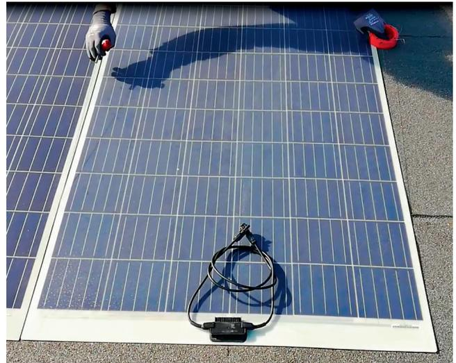
Abb. 11: Demontage von geklebten Modulen mittels Schneidraht.
